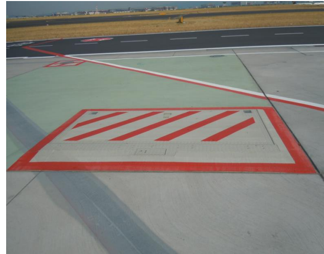
Tankpit/Wartungsschacht (grün markiert/rot schraffiert)
