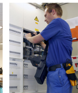
Überprüfung der Elektroinstallation
