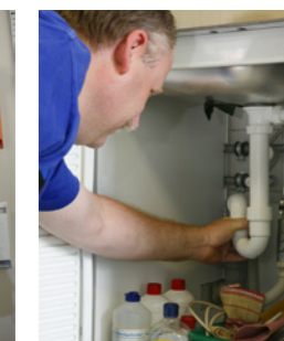
Instandhaltung von Sanitäranlagen
