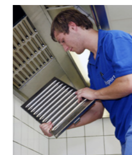
Kontrolle und Austausch von Filtern im Küchenbereich
