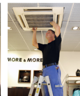
Instandhaltung von Klimaanlage
