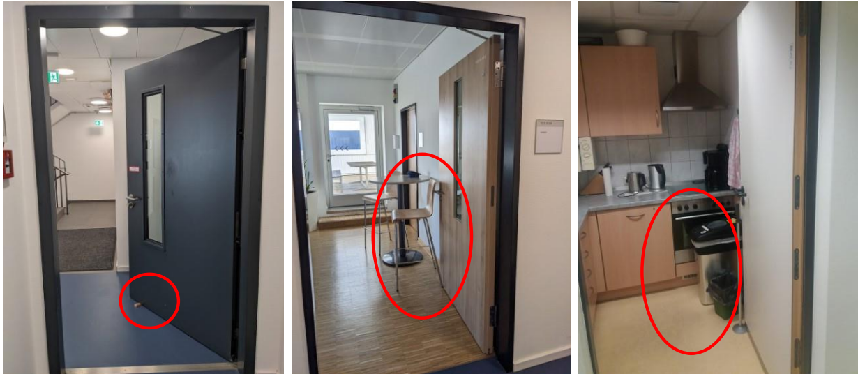
Abbildung 5: Außerbetriebsetzung Brandschutztür
