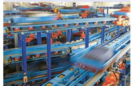
Unzählige Rollen, Gurte und Motoren bringen die Gepäckwännen mit den Koffern von A nach B. Neben dem Einsatz energieeffizienterer Antriebe sollen insbesondere die Laufzeit sowie Reibungsverluste reduziert werden, um Energie zu sparen. Diese Maßnahmen erhöhen durch weniger Verschleiß auch die Abstände, in denen die Anlage gewartet werden muss. Durchgeführte Leistungsmessungen lassen durch die Umsetzung dieser Maßnahmen eine Einsparung von ca. 30% erwarten, dies entspricht ca. 7 GWh pro Jahr.
