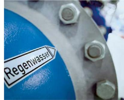
Das aufbereitete Brauchwasser der Regenwassernutzungsanlage versorgt Sprinkleranlagen, Toilettenspülung und Beregnung von Grünanlagen.
