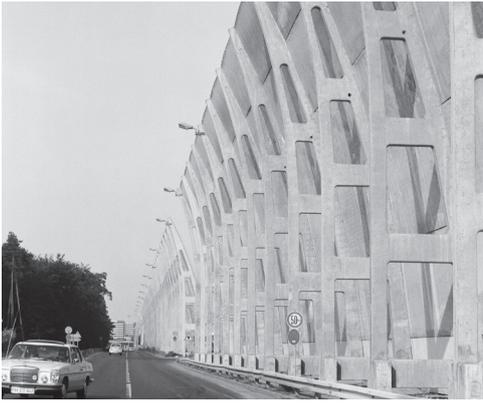
Die alten Wandelemente weichen Elementen, deren Kern aus lärmabsorbierendem Material besteht.
