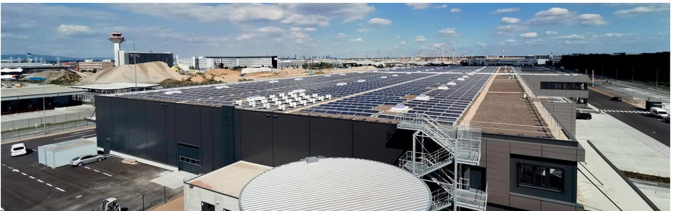
Die erste Photovoltaik-Anlage auf dem Flachdach einer Frachtimmoblie liefert jährlich etwa 1,5 Millionen Kilowattstunden Strom. Zum Vergleich: Damit ließen sich mehr als 450 Haushalte mit vier Personen ein Jahr lang mit Strom versorgen. Dieser Sonnenstrom fließt in verschiedene Liegenschaften am Flughafen.
