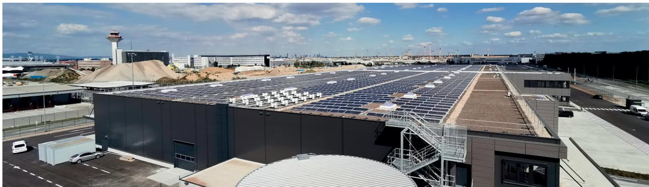
Die Photovoltaik-Anlage erzeugt jährlich etwa 1,5 Millionen Kilowattstunden Strom. Zum Vergleich: Damit ließen sich mehr als 450 Haushalte mit vier Personen ein Jahr lang mit Strom versorgen. Der Sonnenstrom aus eigener Produktion fließt in verschiedene Liegenschaften am Flughafen und wird später auch im Terminal 3 zur Klimatisierung sowie für den Betrieb weiterer Gebäudetechnik wie Beleuchtung, Fahrstühle, Rolltreppen und ähnliche Einrichtungen genutzt werden.
